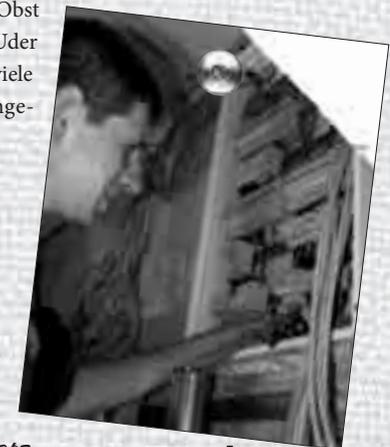
Auf der Sommerbauhütte wurde weiter an den Jahresaufgaben gearbeitet. Die Großküche hat jetzt Warm- & Kaltwasseranschlüsse bekommen sowie Abwasserleitungen und Rinnen vor den großen Funktionsgeräten. Auch Gasanschlüsse für Hockerkocher und einen Gasherd liegen schon. Die Leichtbauwände sind gestellt worden und die Gipskartonplatten sind auch schon angebaut und verspachtelt wurden. Der Schornstein in der Großküche ist auch mit Platten verkleidet worden.
